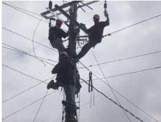
Figura. N.º 13. Mantenimiento herrajes Fuente: autor
