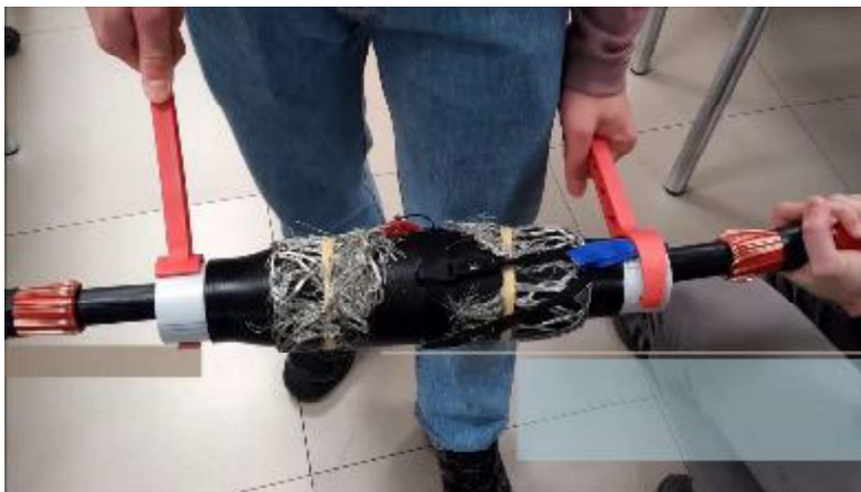
Figura. N.º 9. Mantenimiento empalmes Fuente: autor
