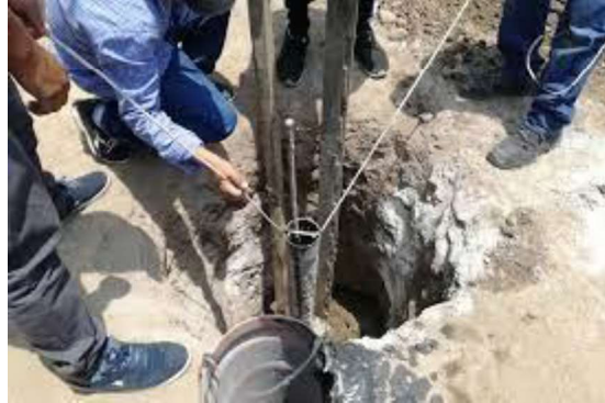
Figura. N.º 8. Mantenimiento sistemas de puesta a tierra Fuente: autor
