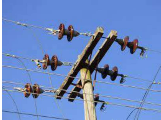
Figura. N.º 11. Mantenimiento cadena de aisladores Fuente: autor
